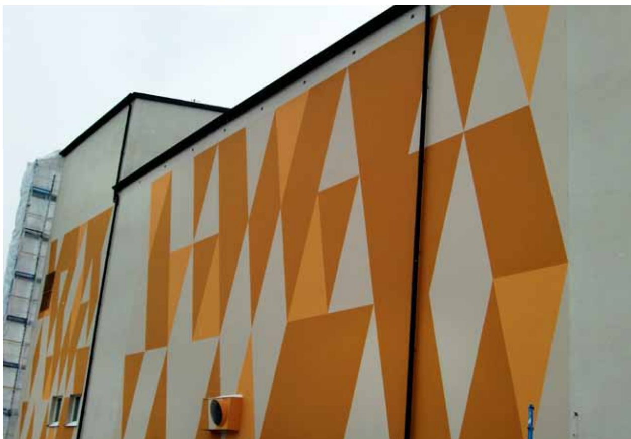
Renoveringen av före detta Folkets hus startade. Gaveln mot centrum fick en ny målning.
