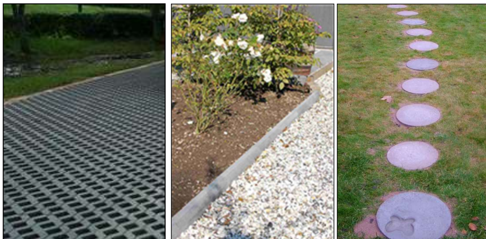
Figur 3:8. Yta med hålsten av betong, makadambelagd gång, samt gångstig med gräs och några gångplattor i betong (Foto: Norconsult).
