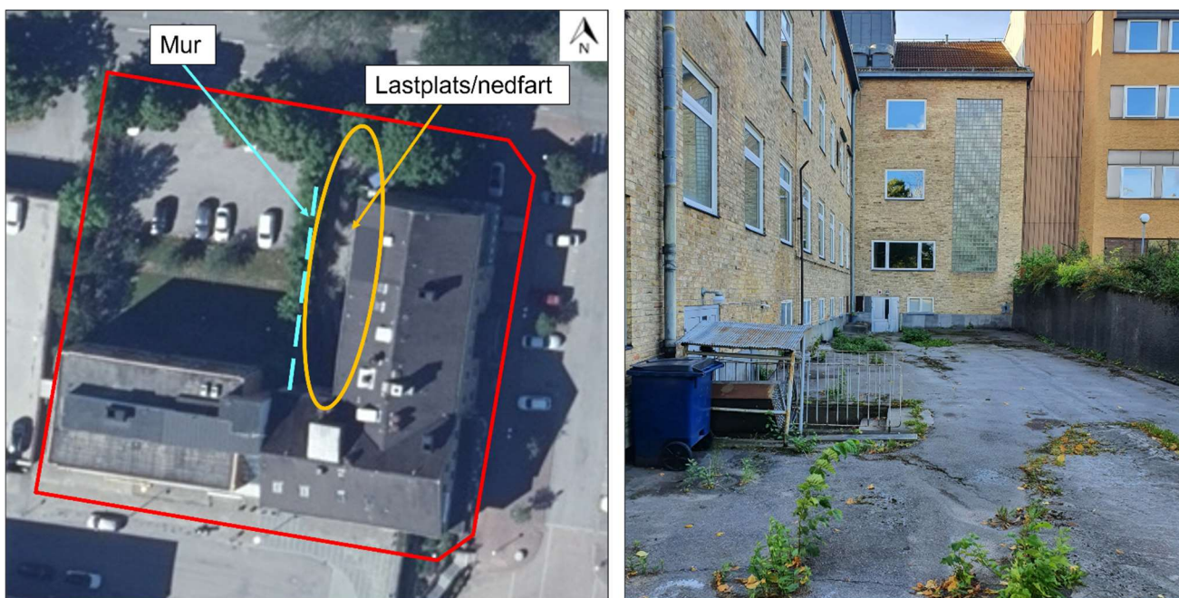
Figur 1:2. Till vänster: Befintliga förhållanden ovanifrån. Fastighetsgränsen är markerad i rött, lastplatsen är inringad i orange och muren är markerad med en ljusblå streckad linje. Till höger: Lastplatsen/nedfarten med muren till höger i bild. Bild tagen i sydlig riktning.
